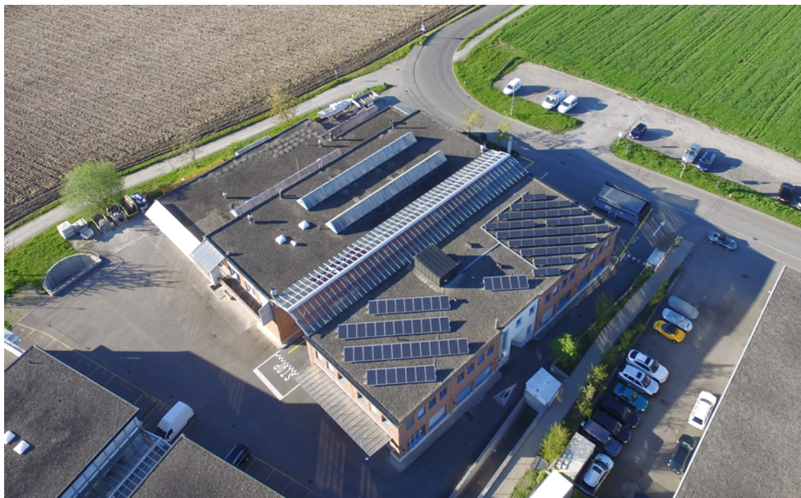
Abb. 6: Solaranlage Schwättenmos / Werkhof Zumikon
