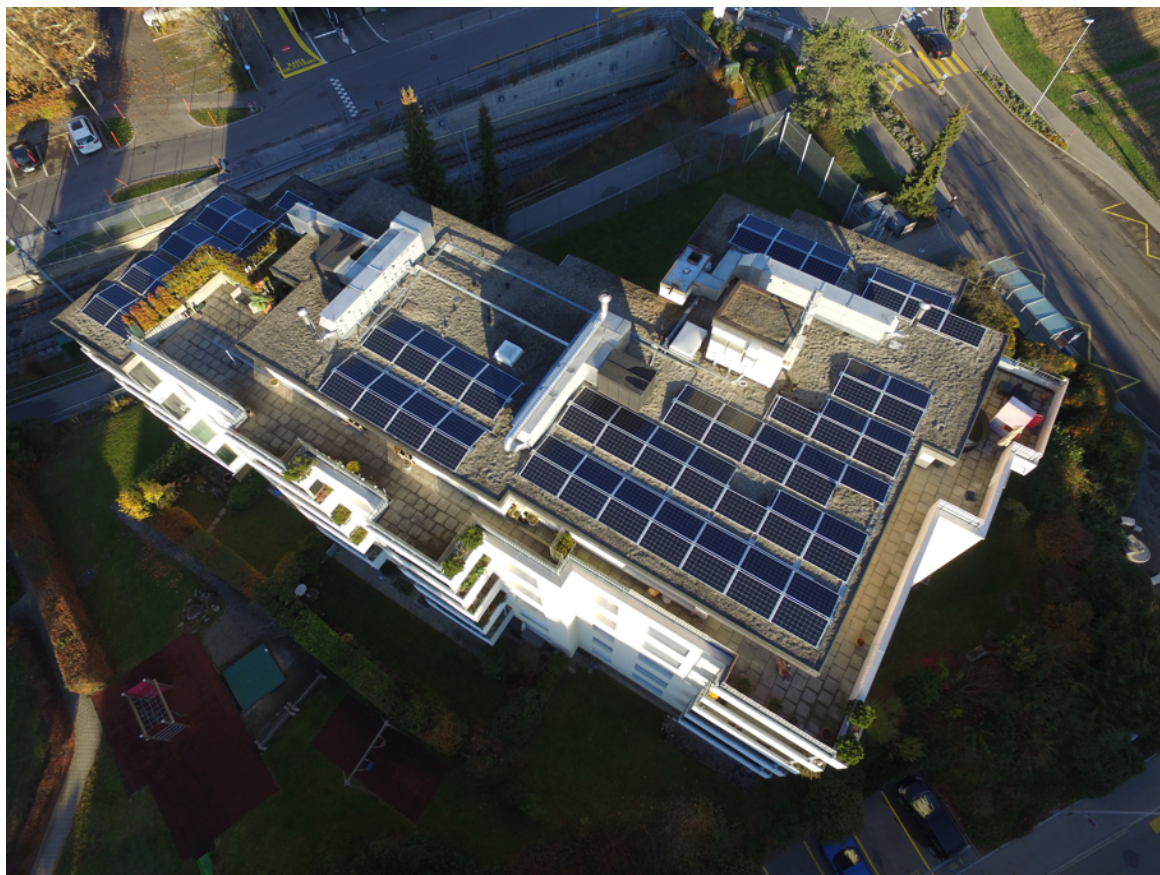
Abb 2: PV Anlage In der Gandstrasse 4 (IdG4)
